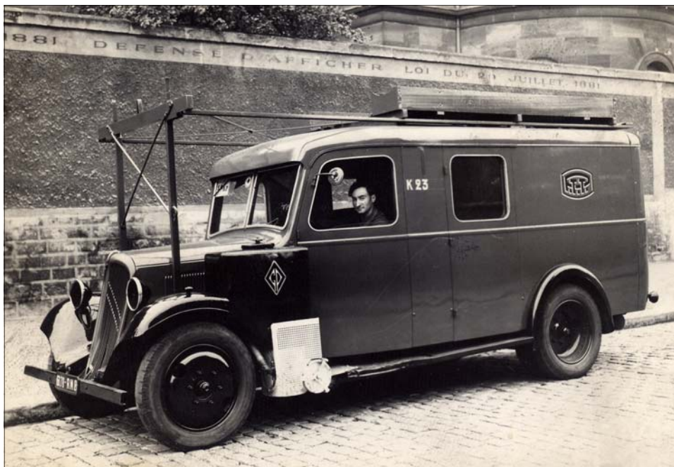
FIG. 4 – Citroën T23 à gazogène.
