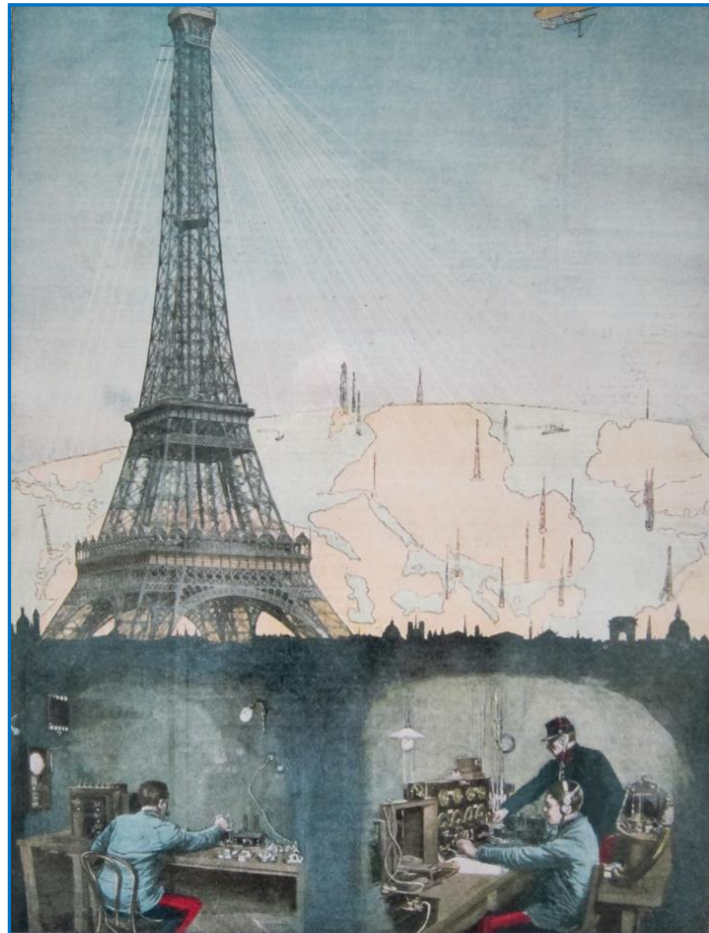
Intérieur de la station souterraine de TSF
