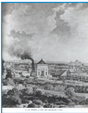
FIG. 10. – Pompe à feu de Chaillot, 1781. Wikipédia.
