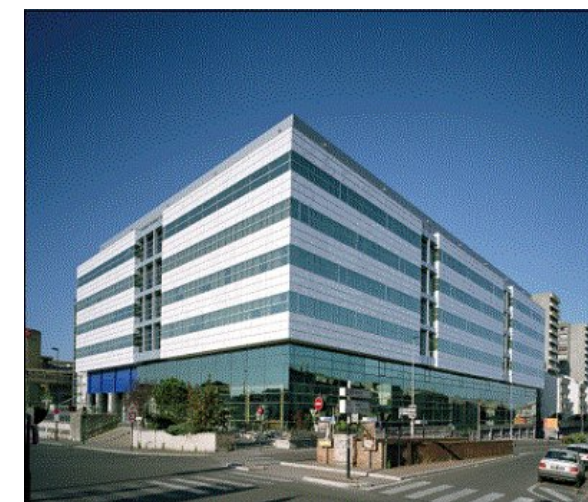
Le bâtiment des Chèques postaux de Bordeaux.
